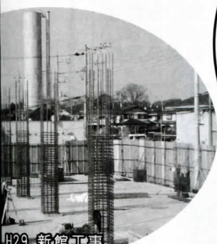
H29 新館工事
