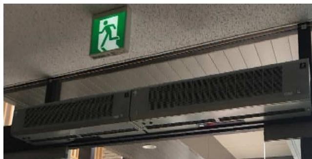
入口上部に外気を入れず中の空気を外に出さないようにする空調設備
