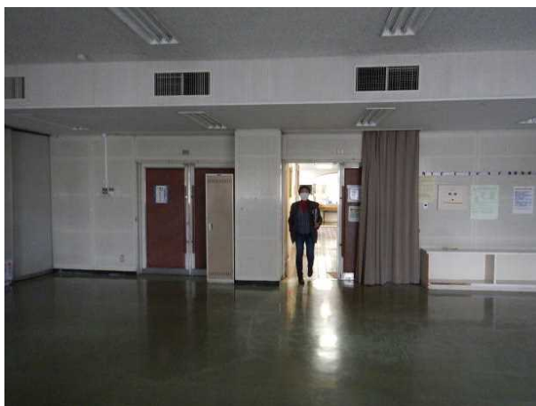
大会議室廊下側出入口
