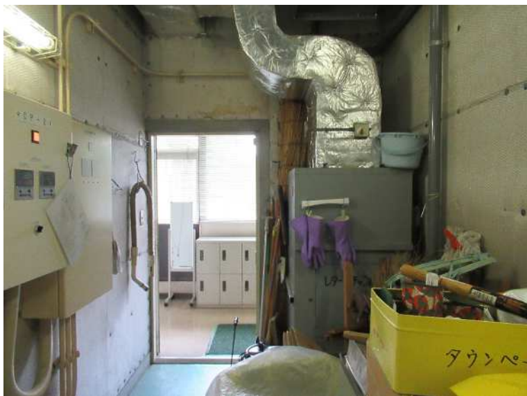
○倉庫・機械室
