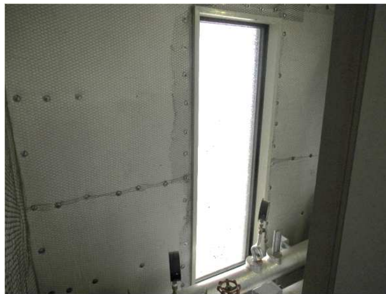
○倉庫・機械室 天井
