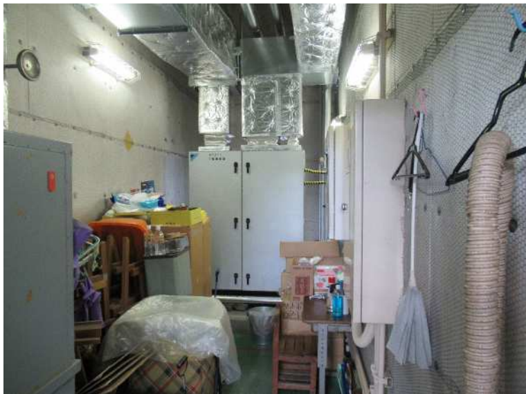
○倉庫・機械室
