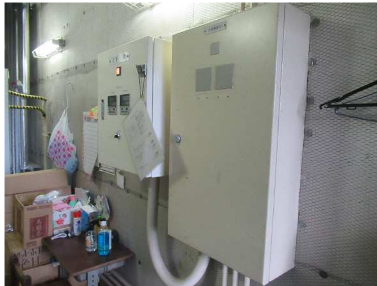
○倉庫・機械室
