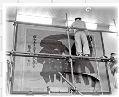
ロビーの大きな額「 蘇 」 取り外し工事を実施
