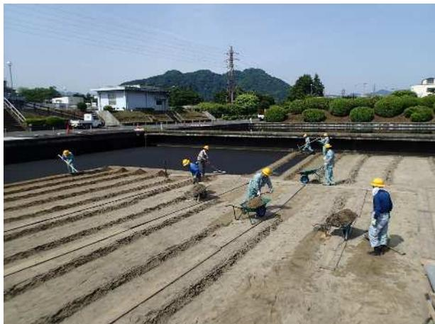
緩速ろ過池の人力砂面削り取り作業
